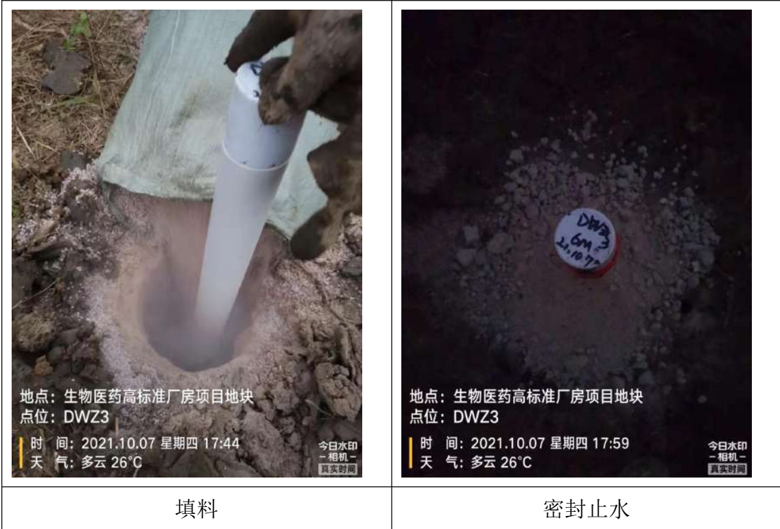
图 4-5 地下水监测井建井过程示例
