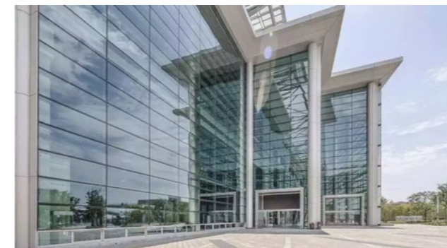
苏州市会展中心地下室防水堵漏维修
