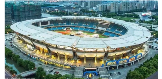
苏州市体育中心场馆维修改造
