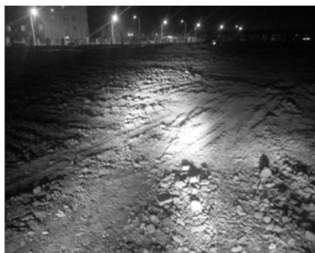
图 1 拆除的碎砖和废混凝土块用于基础回填
