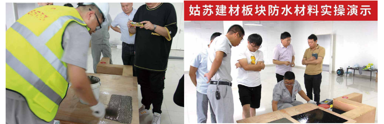
两种防水涂料 / 施工演示
