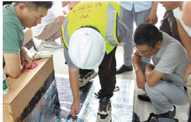
自粘聚合物改性沥青防水卷材 / 施工演示
